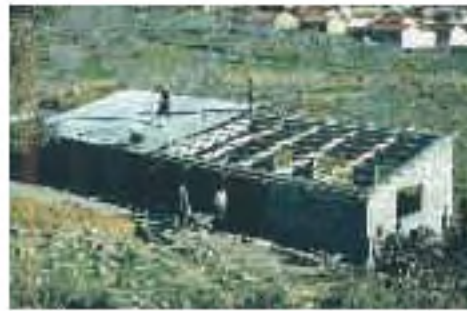
164. La construction de l'école de Sahel.
