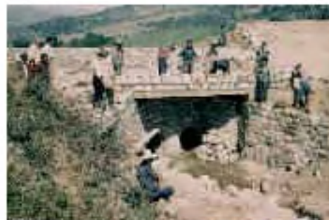
170. Le pont d' Ahncq en voie d'achèvement
