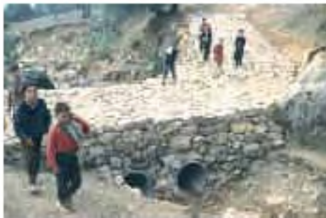
163. L'empierrement de la piste de Bouzeguene et Sahel.
