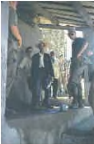
161. Inauguration du réservoir à Bouzeguène. Au centre, Amroun Tahar avec son chapeau. À gauche le sous lieutenant médecin du 27 e B.C.A.
