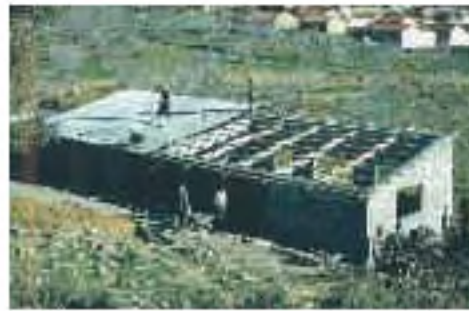
164. La construction de l'école de Sahel.
