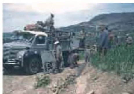
150. Le camion Berliet qui va permettre le transport des colis, des matériaux pour les travaux.
