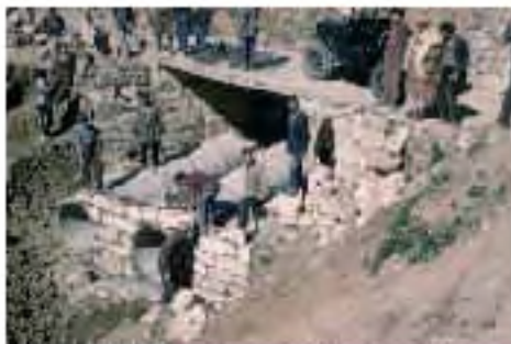
169. Pont d' Ahncq en cours de construction
