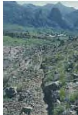
165. La tranchée d'amenée d'eau vers Habura.
