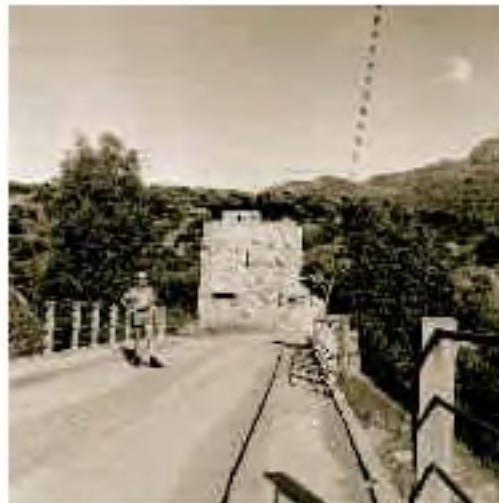
129. Enjambant l'Acif ou Serdoun, le pont de Youssof, gardé par un détachement de chasseurs.
