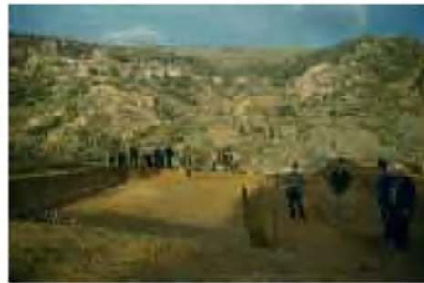
162. Construction de l'école d'Ait Saïd
